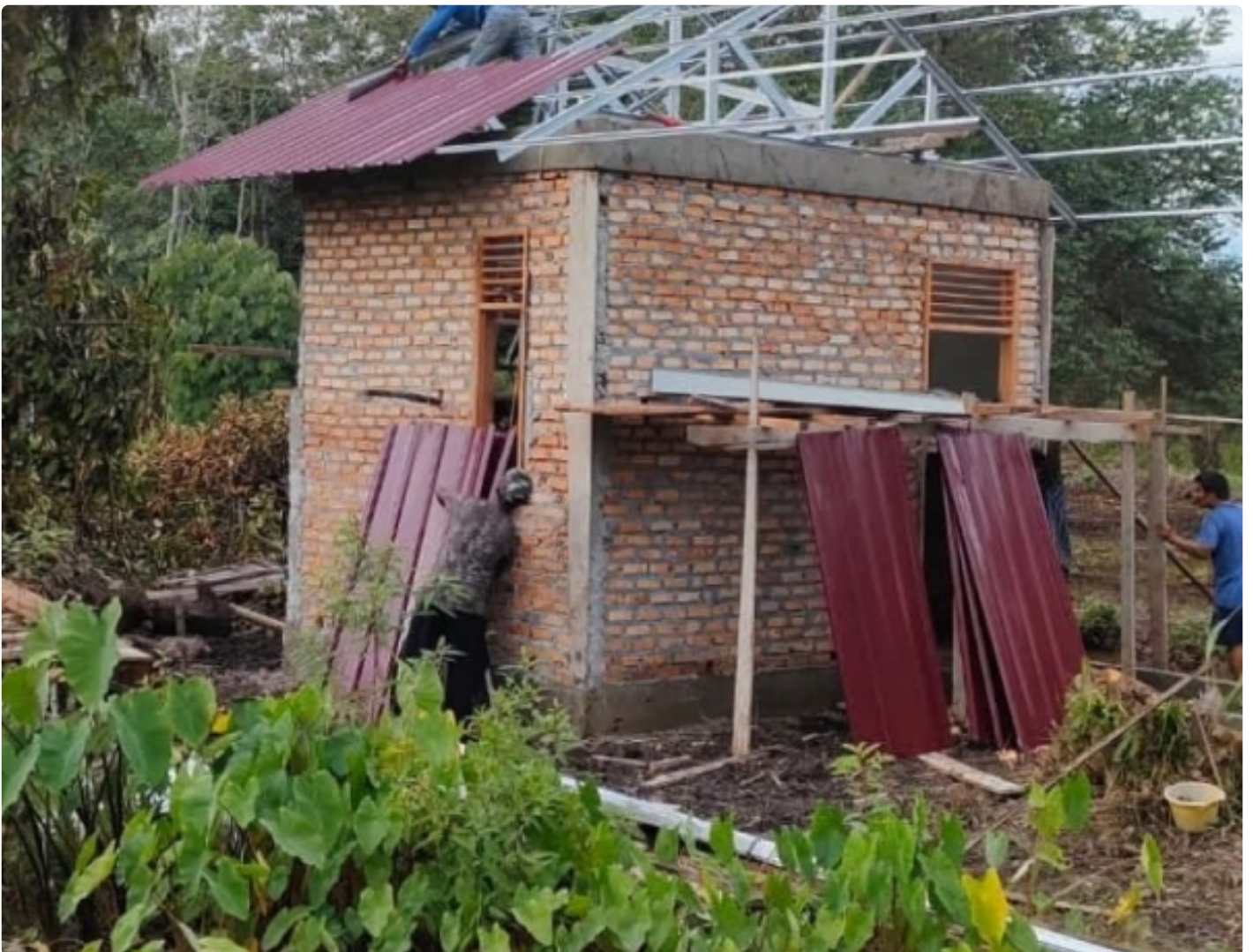
Progres pembangunan rumah Syahrudin desa teluk Latak
